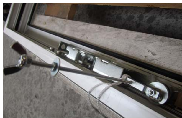
Vue verrou avec dispositif de déverrouillage
